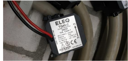
Voorbeeld van een stroomtrafo (C1, C2 en C3)
