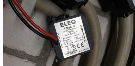
Voorbeeld van een stroomtrafo (C1, C2 en C3)
